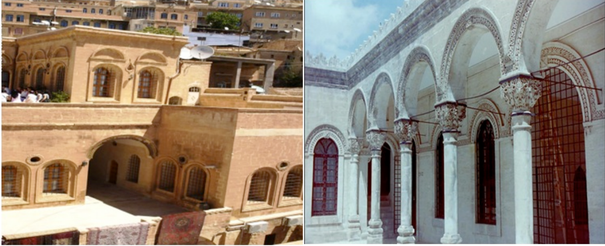
Şekil 5. Teras ve dam örneđi
