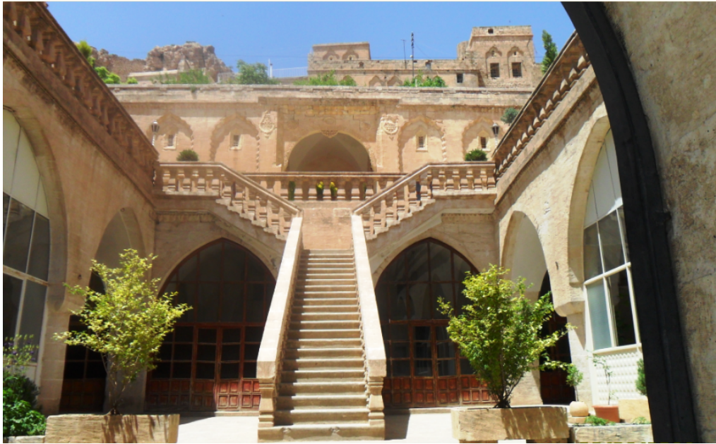
Şekil 6. Bir avlunun merkezinde 'U' şeklinde dizilmiş revaklar, odalar ve eyvanlardan oluşan bir yapı
